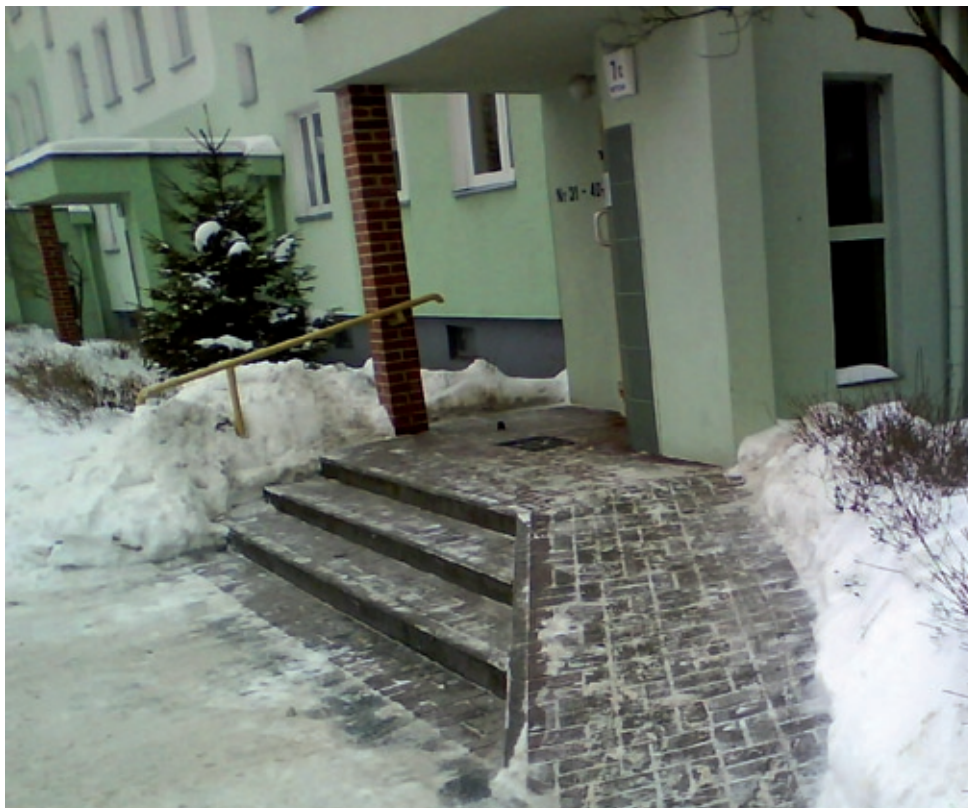
Gospodarze domów w pierwszym rzędzie odśnieżają i posypują piaskiem najbardziej ruchliwe miejsca na naszym osiedlu, począwszy od wejść do klatek schodowych
