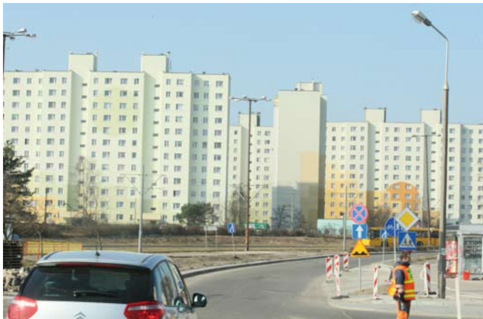
Na Konstytucji 3-go Maja drogowcy kończą remont, który w ubiegłym roku przerwała zima
