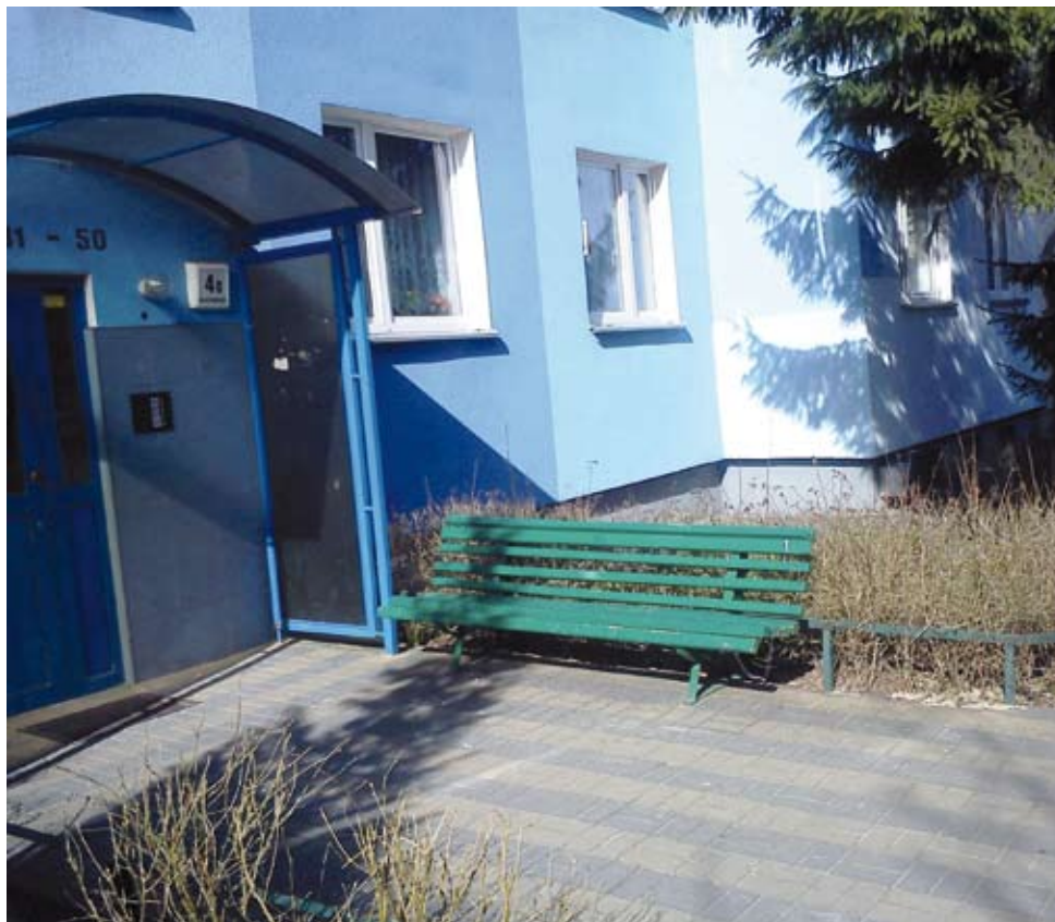
Ławki na okres zimowy są chowane, w celu umożliwienia przejazdu ciągników i łatwiejszego odśnieżania.
