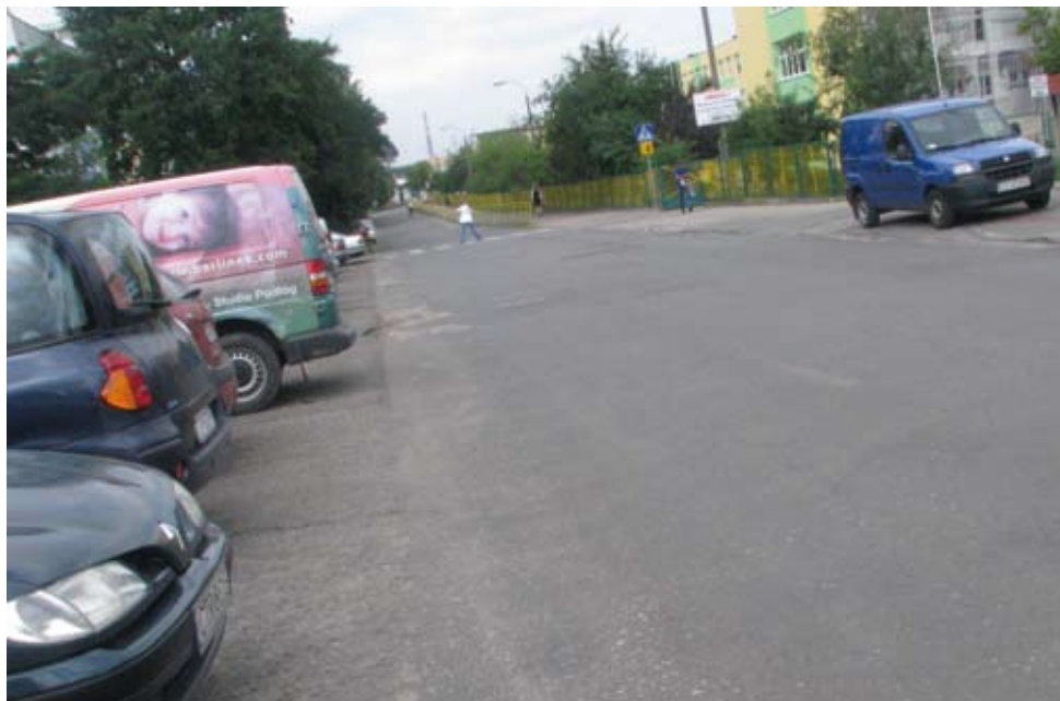
Dzięki oszczędnościom w przetargach ta ulica zostanie w tym roku wyremontowana
