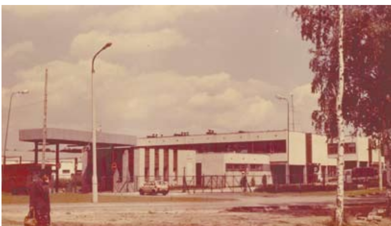
Zakład remontowo-budowlany w sektorze Anna
