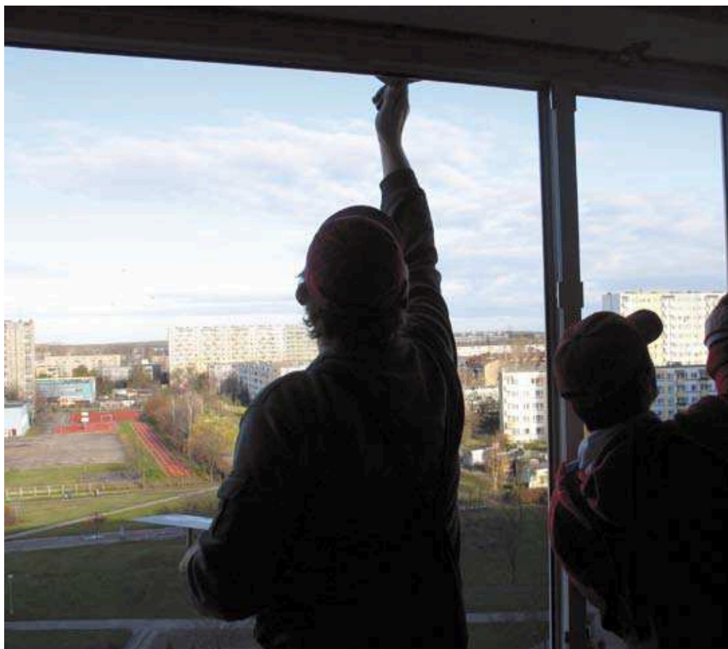
K&K to wysokiej jakości okna i profesjonalny montaż
